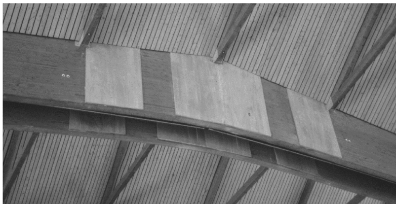
Abbildung 29: außen liegende Verstärkung im Firstbereich – aus optischen Gründen nur für Sanierungszwecke empfehlenswert
